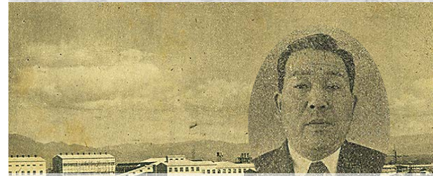
Akita Smelter & Refinery kurz nach der Aufnahme des Betriebs (Herr Nakayama, der erste Direktor von Akita Smelter & Refinery, ist durch den Kreis markiert.)
